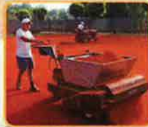
Stivare con terra battuta di prima qualità/laying court with top quality clay/empilage de clay de qualité supérieure/Aufbauung mit top Qualität-Sand
