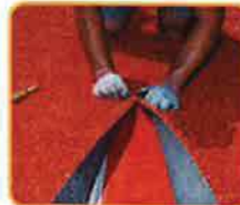
Indagare e stendere del supporto/stocking and cover support/Indagare et stendere du support/stocking und Schließen der Oberfläche
